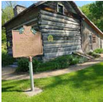
Miller-Leuser Log House
